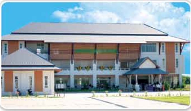
▶ อาคารศูนย์สุขภาพชุมชนเทศบาลเมืองเวียงคันทคร
