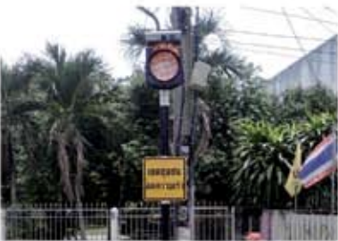
โครงการติดตั้งไฟกระพริบพลังงานแสงอาทิตย์ ติดตั้งภายในเขตตำบลปงแสนทอง อำเภอเมือง จังหวัดลำปาง
