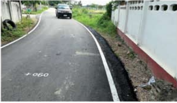
โครงการปรับปรุงถนนเดิมด้วยแอสฟัลท์ติกคอนกรีตภายในชุมชนบ้านหนองบัว หมู่ที่ ๕ ตำบลปงแสนทอง อำเภอเมือง จังหวัดลำปาง
