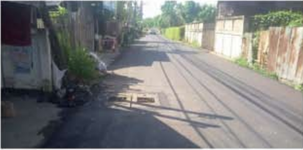
โครงการปรับปรุงถนนเดิมด้วยแอสฟัลท์ติกคอนกรีตสายหลักในชุมชนบ้านศรีปงชัยต่อจากถนนแอสฟัลท์ติกคอนกรีตเดิมถึงชุมชนบ้านยาเป่าบริเวณคลองชลประทาน หมู่ที่ ๖ ตำบลชมพู อำเภอเมือง จังหวัดลำปาง
