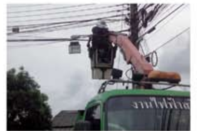
ซ่อมแซมไฟที่ชำรุดในเขตตำบลพระบาท และตำบลกล้วยแพะ
