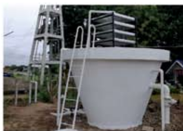
โครงการปรับปรุงระบบประปาหมู่บ้านลำปางกลางตะวันตก หมู่ ๓ ตำบลปงแสนทอง อำเภอเมือง จังหวัดลำปาง
