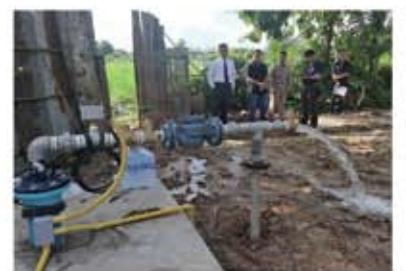
โครงการปรับปรุงระบบประปาหมู่บ้านภายในชุมชนบ้านหนองห้า ตะวันออก หมู่ ๗ ตำบลพระบาท อำเภอเมือง จังหวัดลำปาง
