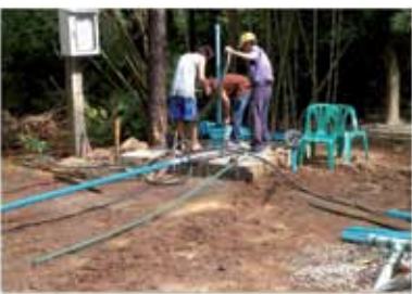
โครงการปรับปรุงระบบประปาหมู่บ้านชุมชนบ้านกล้วยหลวง หมู่ ๑ ตำบลกล้วยแพะ อำเภอเมือง จังหวัดลำปาง
